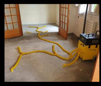
Permet l'asséchement de l'eau ou de l'humidité se situant entre la dalle et la chape ou dans un doublage mural (isolation) par aspiration ou insufflation d'air.
