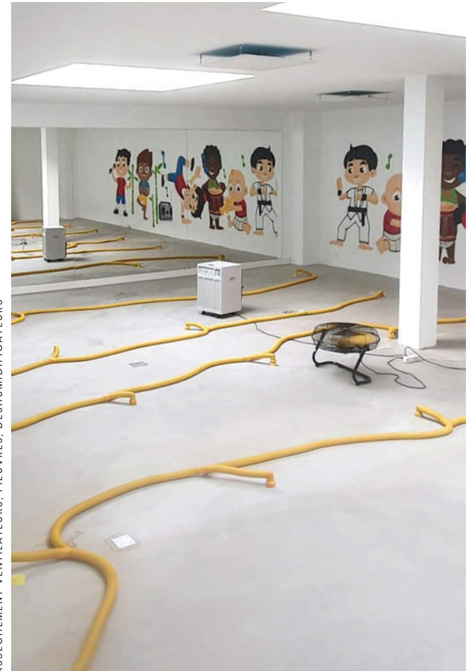
ASSÈCHEMENT VENTILATEURS, PIEUVRES, DÉSHUMIDIFICATEURS
